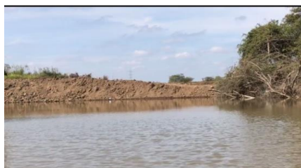
Figura 3. Barragem reestruturada, em 14/05/2022.
